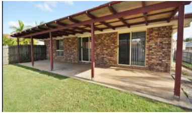
12 Adraan Court, Dakabin
