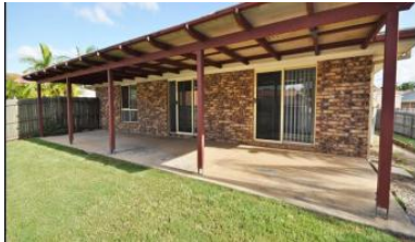
12 Adraan Court, Dakabin
